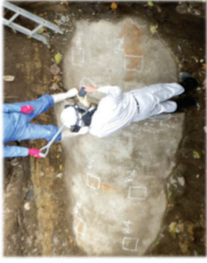
試掘による管外面調査
