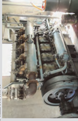
施設整備補修
