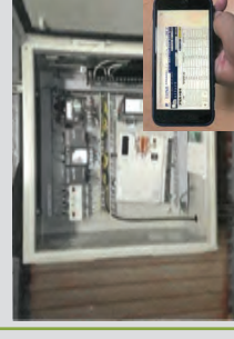
監視装置の設置
