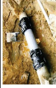
漏水防止のための整備
