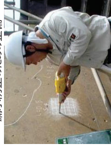
老朽化した施設の機能診断
