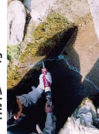
水路のひび割れ補修
