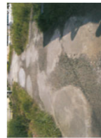
水路のひび割れ補修
