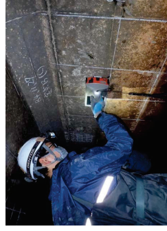
水路の鉄筋探査状況
