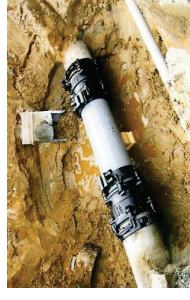
漏水防止のための整備
