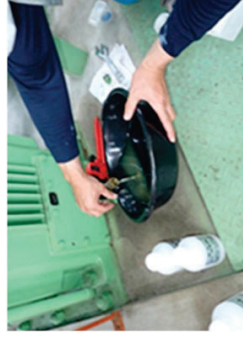
ポンプ設備を分解することなく、潤滑油採取による診断技術の確立
