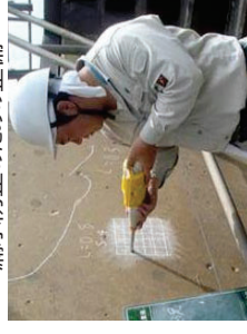
老朽化した施設の機能診断
