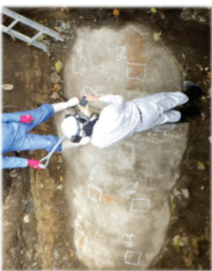
試掘による管外面調査
