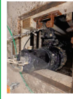
集落排水施設の更新（ポンプ）
