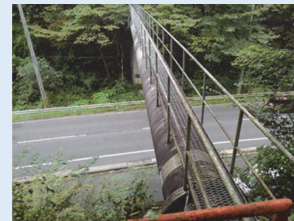
道路上にある老朽化した水管橋
