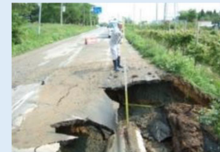
パイプライン破損による道路陥没
