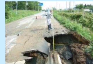
パイプライン破損による道路陥没
