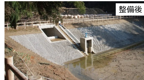
堤体の補強及び法面保護による浸食防止
