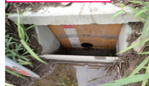
流出調整板設置の例
