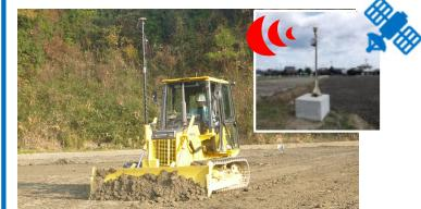
衛星測位による機械制御
