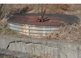
老朽化した集水井工の例
