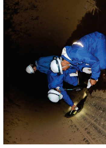
管水路の機能診断
