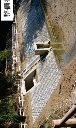
堤体の補強及び法面保護による浸食防止
