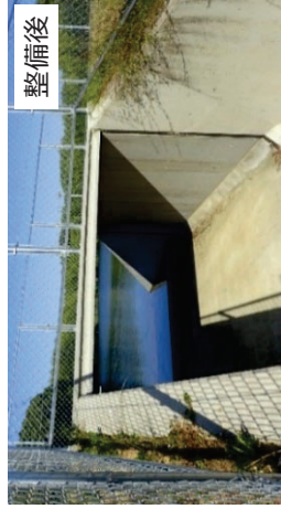
ため池の洪水吐きの改修（洪水流下能力の増加）
