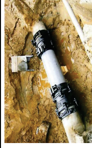
漏水防止のための整備
