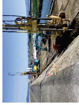
耐震対策（地盤改良による施工）
