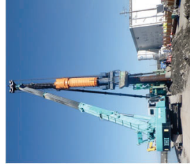
耐震対策（鋼管杭による施工）
