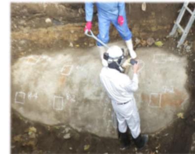
試掘による管外面調査
