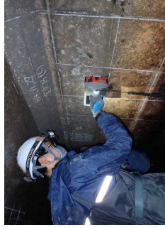
〔水路の鉄筋探査状況〕
