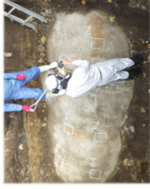
試掘による管外面調査
