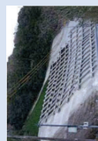
集落防災安全施設 (土砂崩壊防止施設)
