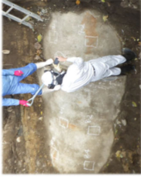
試掘による管外面調査
