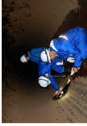
管水路の機能診断
