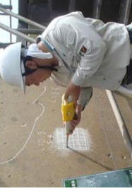
老朽化した施設の機能診断
