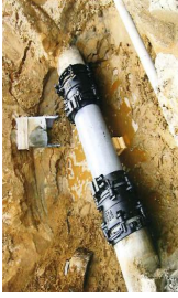
漏水防止のための整備
