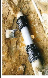
漏水防止のための整備
