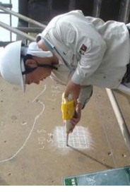
老朽化した施設の機能診断
