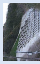
集落防災安全施設 (土砂崩壊防止施設)
