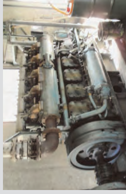
施設整備補修
