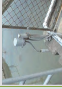
水位計の設置
