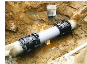
漏水防止のための整備
