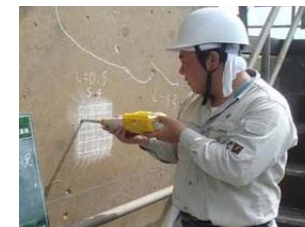
老朽化した施設の機能診断
