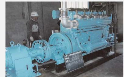
原動機の分解補修、塗装
