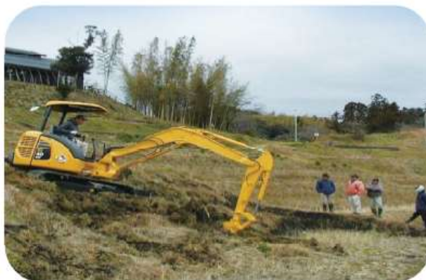
前大塚商会会長より寄贈されたバックホウによる棚田の修繕作業
