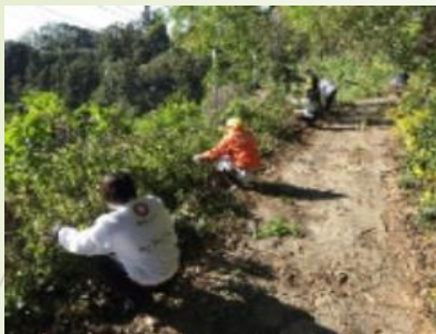
ツタ類の除去作業
