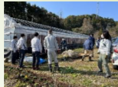
ビニールハウス倒壊箇所撤去
