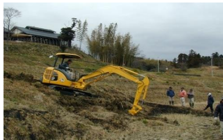
前大塚商会会長より寄贈された バックホウによる棚田の修繕作業
