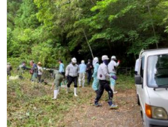
ワイヤーメッシュの補修作業
