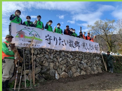
崩落した石積みを空積み工法により修復
