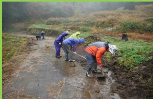
農業ボランティア組織による農道補修
