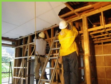
旧消防団詰所を営農組合集会所とジビエ解体施設へ住民の手で改修の様子
