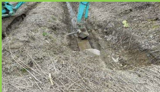
側溝の泥上げ
