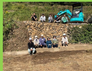
被災した石積みを活用し 石積み講習会を実施
