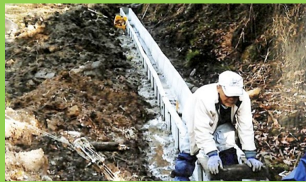
水路の保全作業
