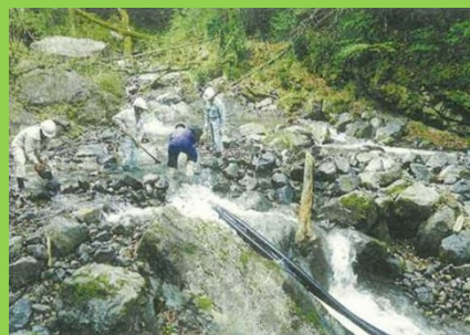
大雨時の復旧作業
