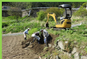
石積み修復作業
