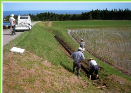
水路の維持管理作業の様子
