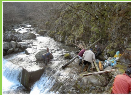
農業用水確保作業の様子
