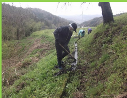
棚田の水路整備作業
