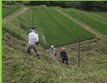
棚田周囲への電気柵設置作業
