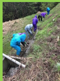
棚田の水路整備作業
