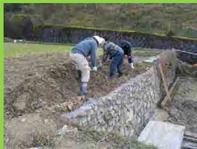
石積みの補修
