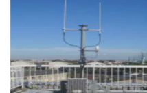
通信施設の整備
