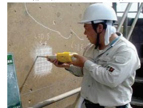
老朽化した施設の機能診断
