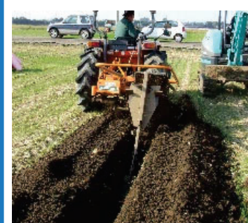
暗渠排水の整備
