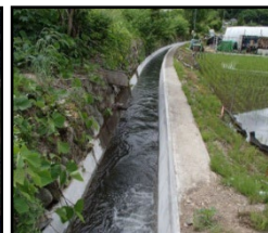
老朽化した用水路の整備・更新
