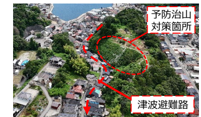
予防治山対策による津波避難路の保全
