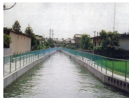
放水路の整備
