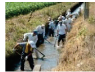
水路の泥上げ
