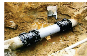
漏水防止のための整備
