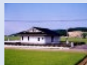
農業集落排水施設
