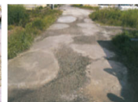
農道の窪みの補修
