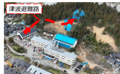
津波避難路となっている山地の被災
