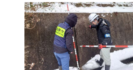
激甚災害後の治山施設の点検支援
