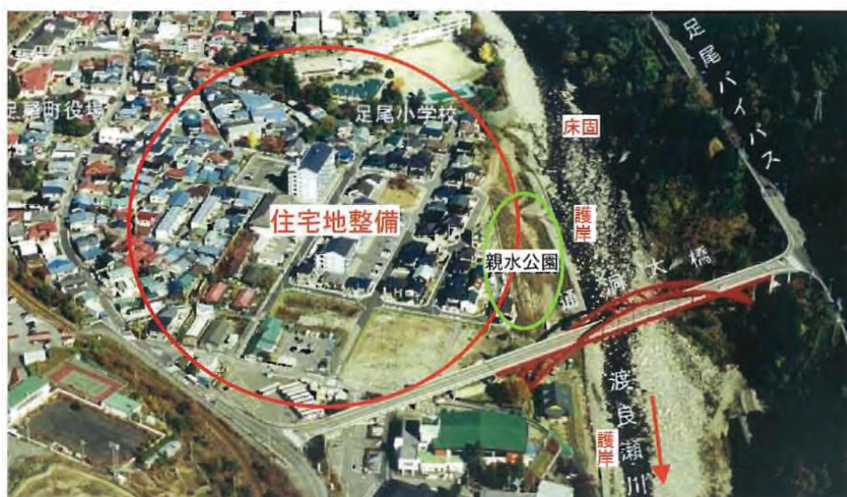
●土砂災害の危険性の高い山間地に安全地帯を創出(栃木県日光市足尾町 渡良瀬川)
