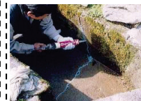
水路のひび割れ補修
