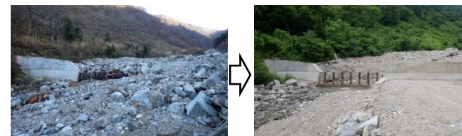
治山ダムに異常堆積した土石・流木の除去
