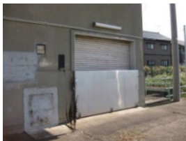
排水機場等の耐水化
