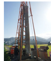
代替水源(井戸)の整備
