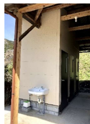
トイレの整備
