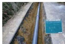
パイプラインの整備
