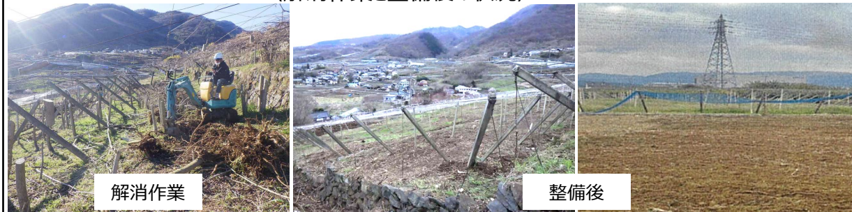
〈解消作業と整備後の状況〉
