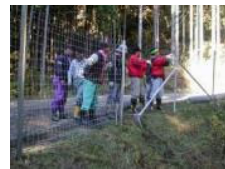
侵入防止柵の設置
