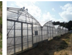
【農業用ハウスの整備】
