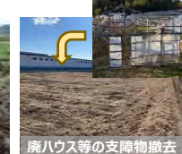
【荒廃農地の支障物撤去】
