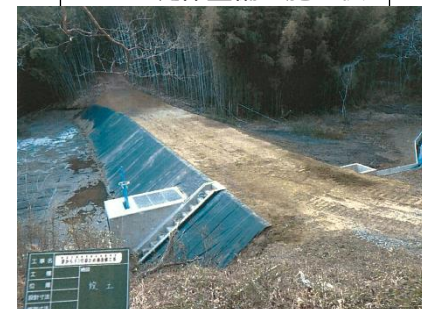
ため池堤体整備：施工後
