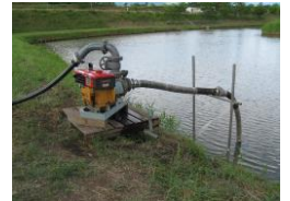
応急ポンプの設置・運転
